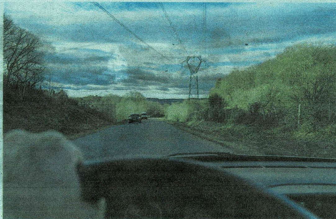
Quatre grands chantiers routiers seront entrepris en 2025.
